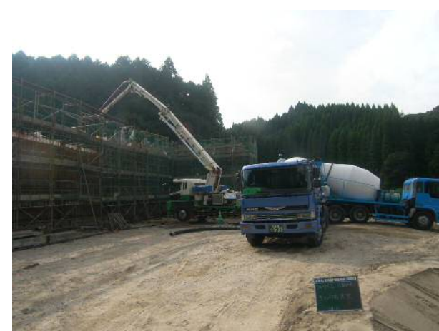
コンクリート打設状況
